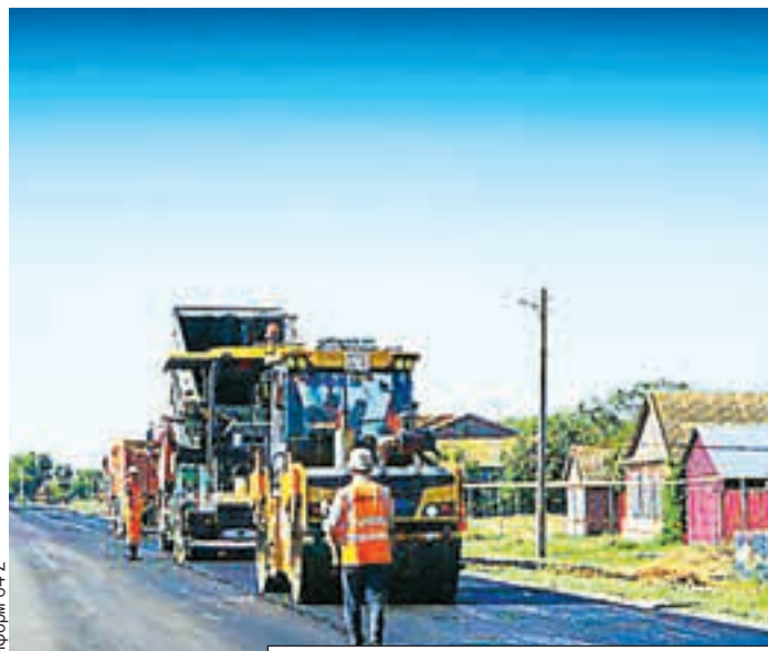
Восстановление изношенного покрытия выполнено по технологии холодной регенерации.
