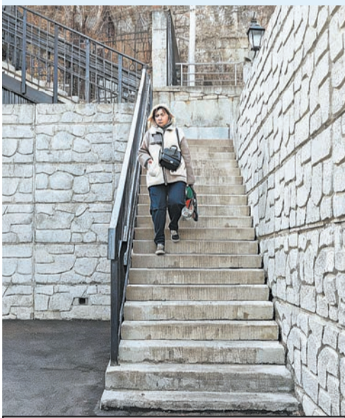
Ремонт лестниц и подпорных стен проводится постоянно.
